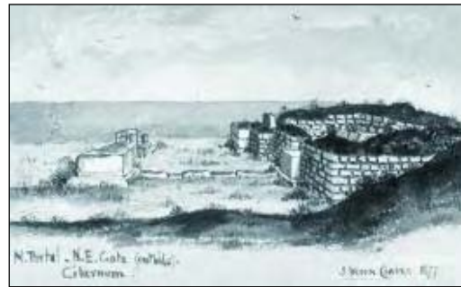
59 N. Portal. N.E. Gate (outside). Cilurnum. 1877 (Fig 67)
