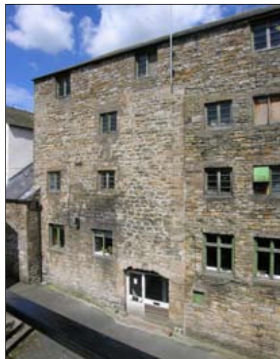
Fig. 40: High Mill, Alston. [DPI35380].
