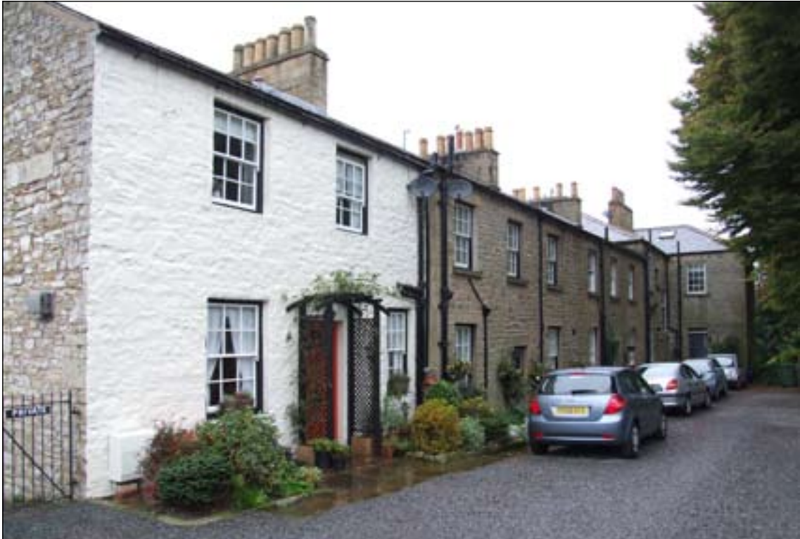
Fig. 61: Croft Terrace, Alston. [DPI35398].
