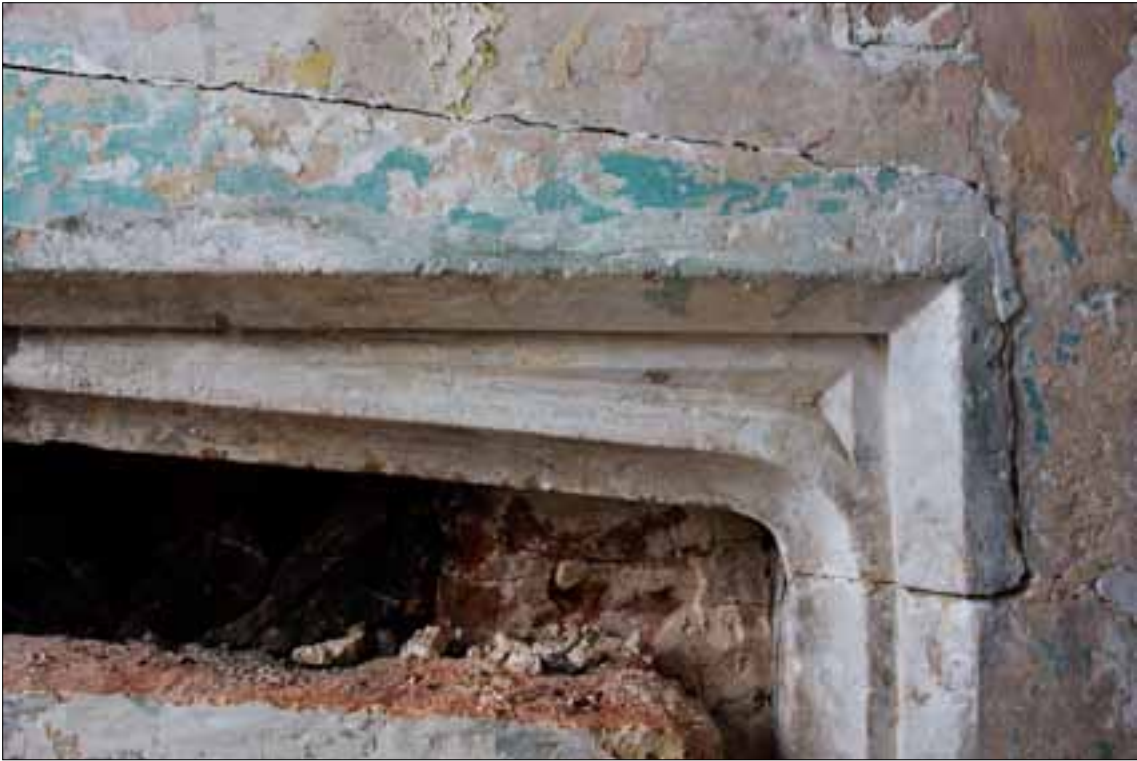
Fig 6. Spandrel detail of fireplace in S3.03. (DPI61395)
