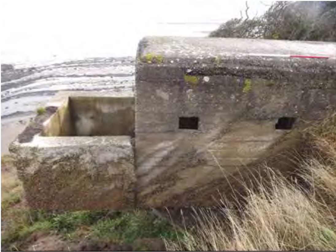
Plate 103 Second World War section post FD60, pour lines at the seaward end
